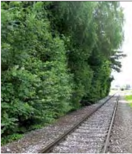
Betriebsgeleise als Nachbar. Wer zahlt den seitlichen Kronenrückschnitt?
